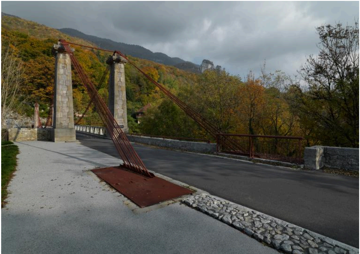
Vue d'ensemble des deux piliers sur lesquels passent les câbles obliques, côté Cusy.
