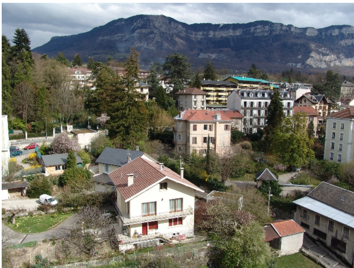
Vue prise du nord-ouest
