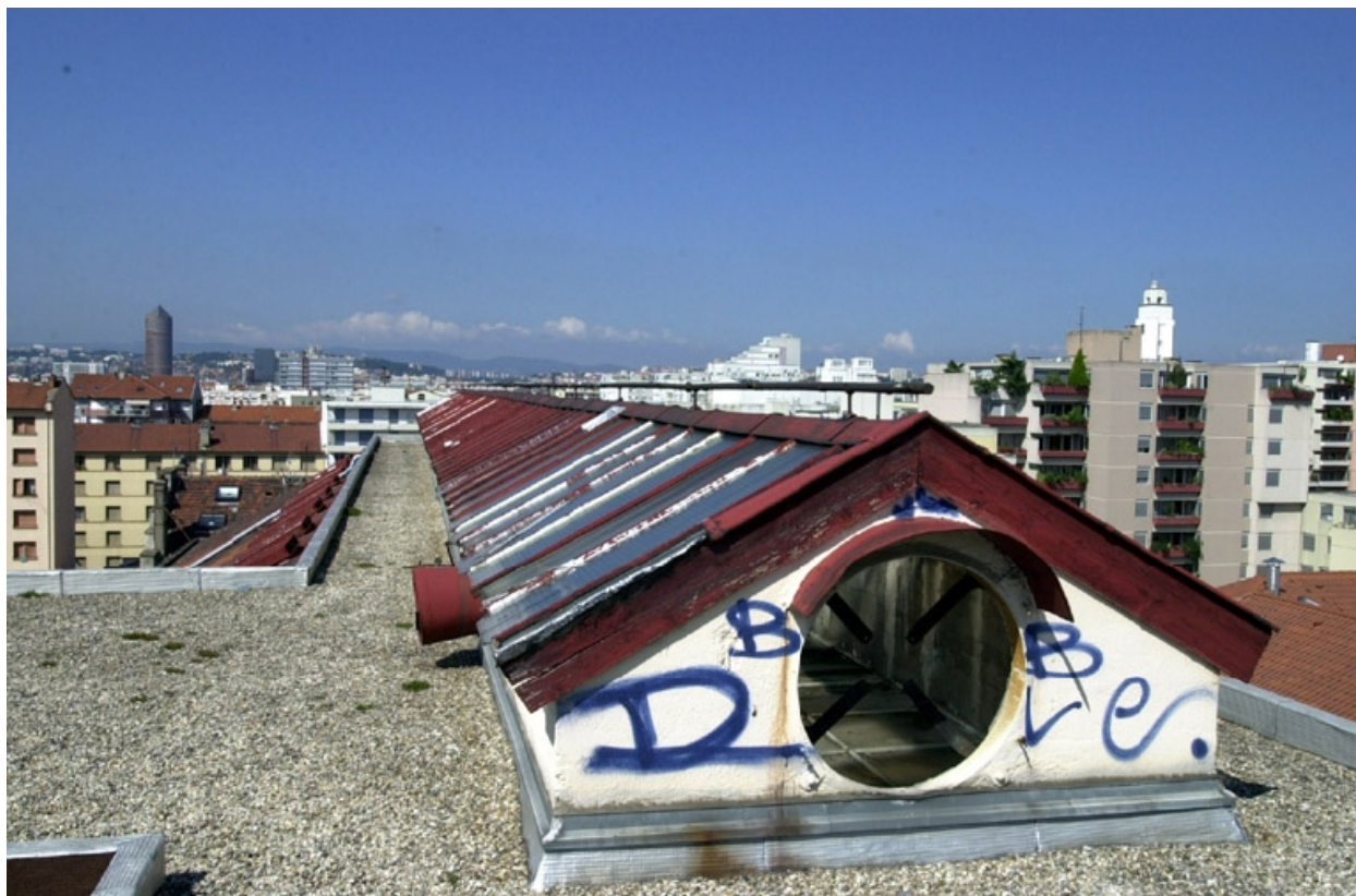
Lanterneau sur toit de l'atelier sous comble
