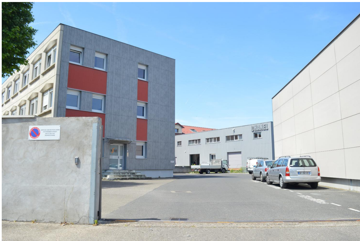
Site du Groupe Chanel Rénovation et isolation de bâtiments - vue depuis la rue de la verrerie - mai 2022
