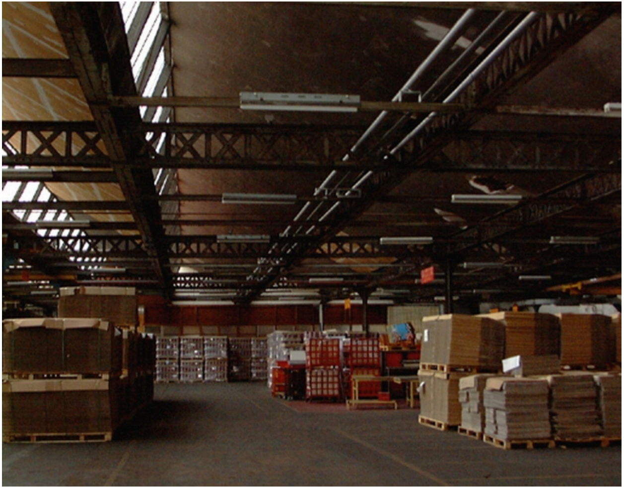
Magasin de stockage
