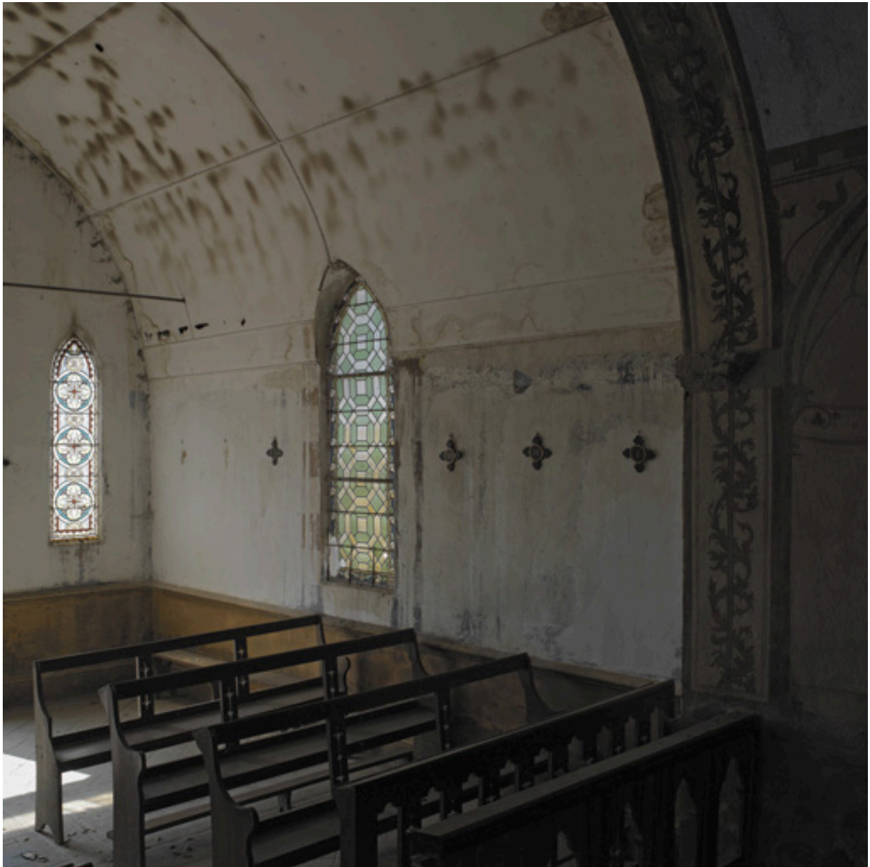
Vue d'ensemble intérieure de la nef, depuis le sud-est.
