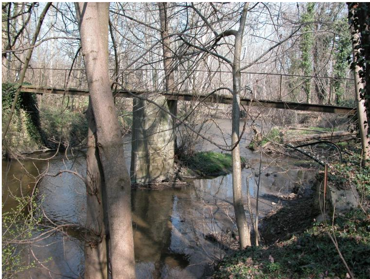
Vue d'ensemble de la passerelle.
