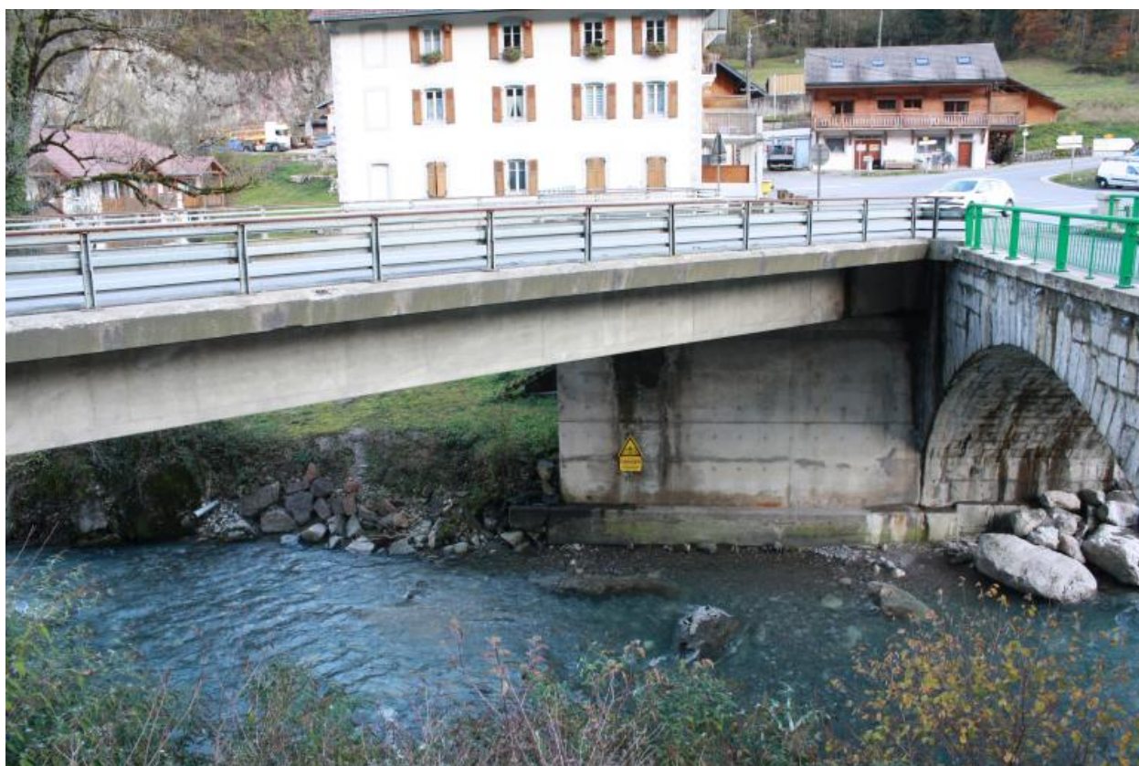
Pont de Gys, face amont droite
