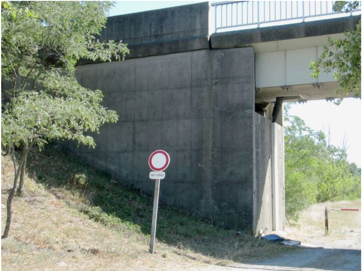
Culée de la rive gauche, face amont
