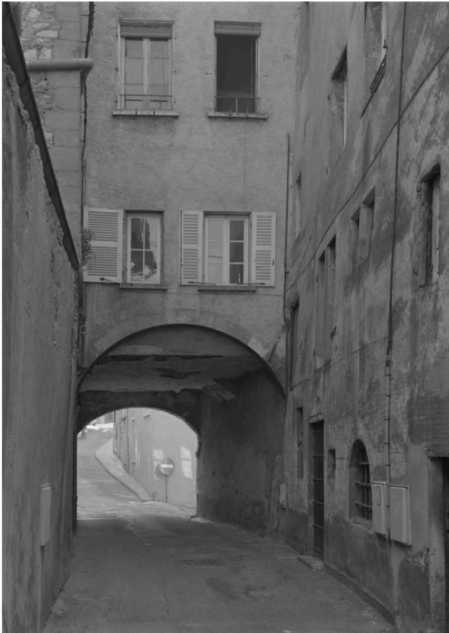
Passage couvert rue de l'Herberie, dit La Voûte, côté ouest.
