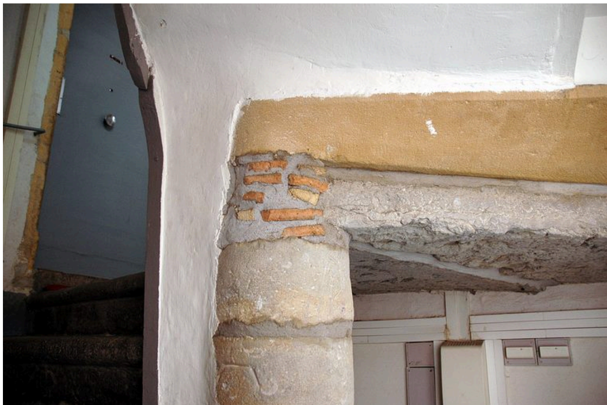
Escalier en vis : détail de matériaux
