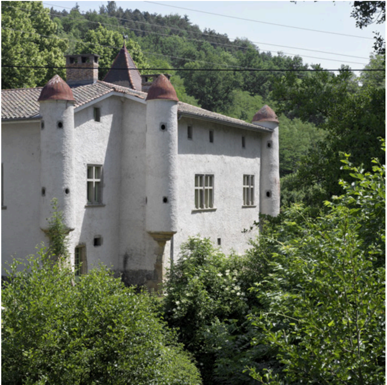
Vue générale depuis le pont sur le Vizézy, au sud-ouest : angle sud-ouest du château.
