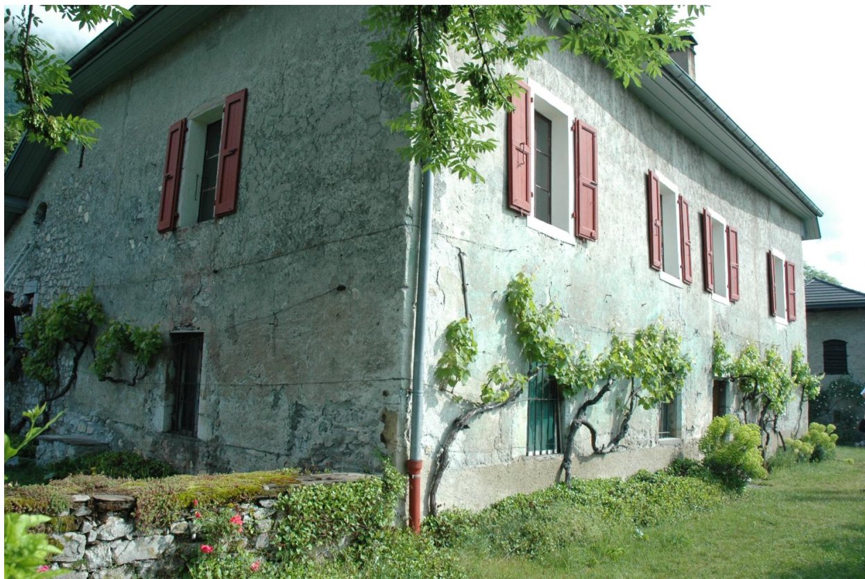
Vue du bâtiment principal depuis le sud-ouest.
