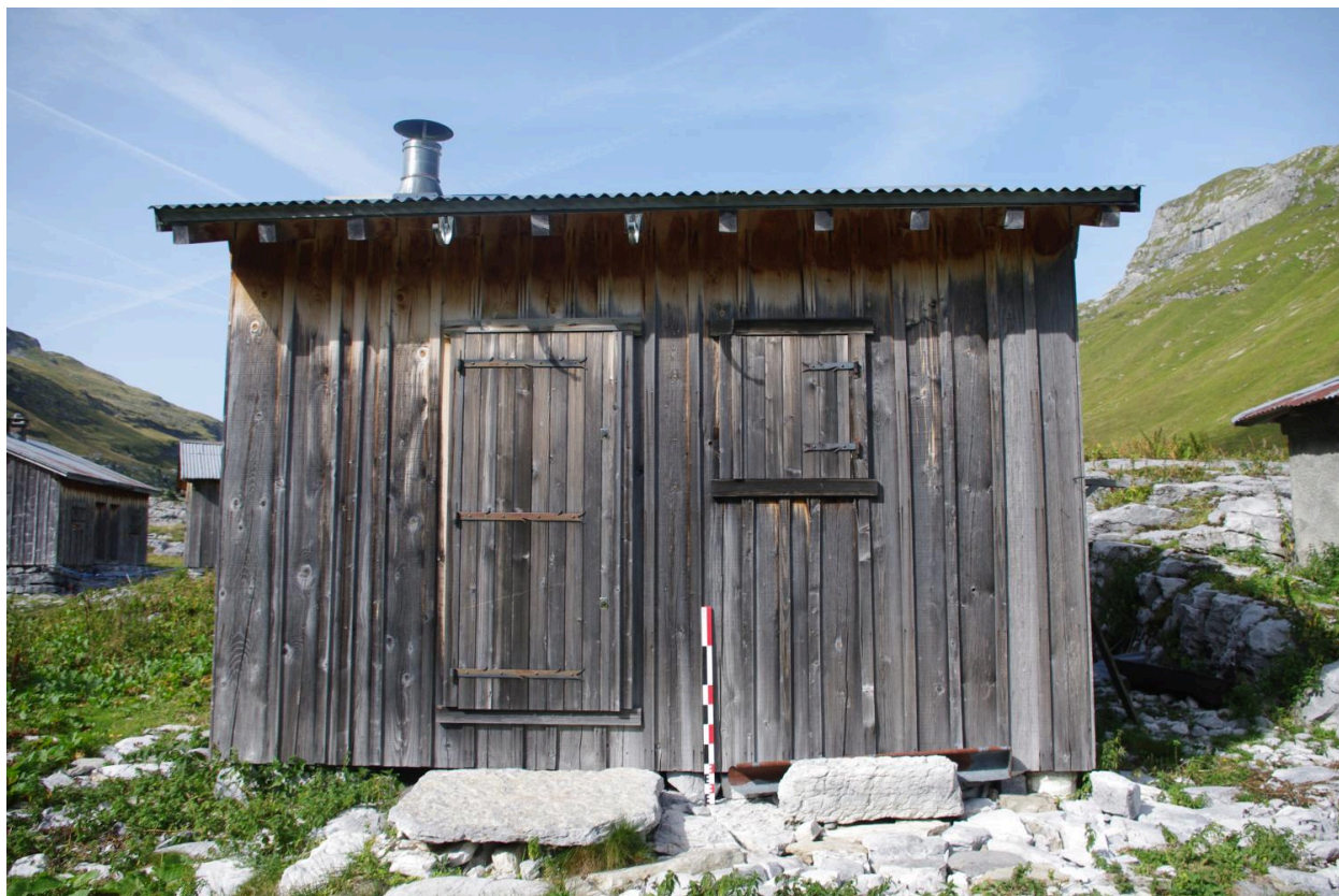
Vue de la façade antérieure sud
