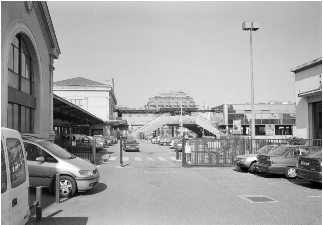
La passerelle entre la gare et le centre d'échanges, depuis l'est
