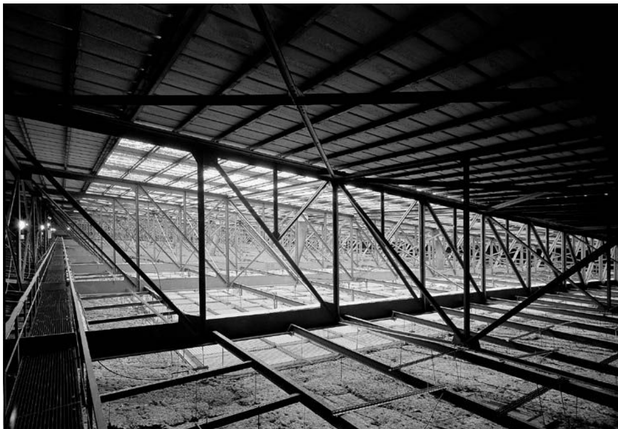
Vue d'ensemble de la charpente métallique
