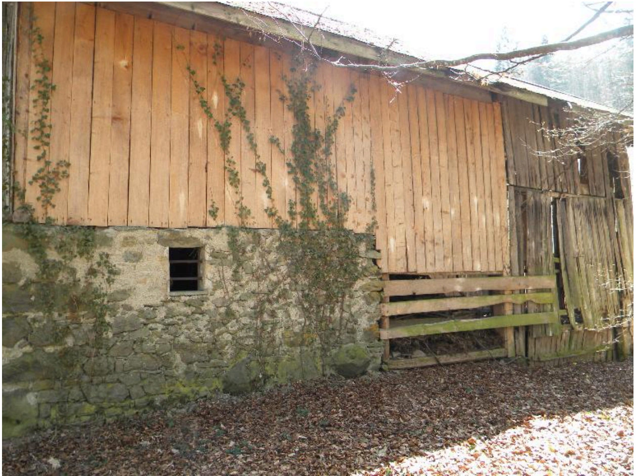
Vue de la façade arrière d'une grange-étable isolée (2008 F6 749).
