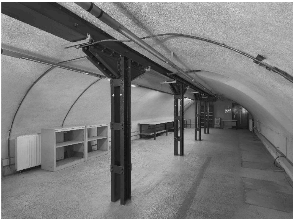
Etage de soubassement voûté en berceau, en-dessous du réfectoire
