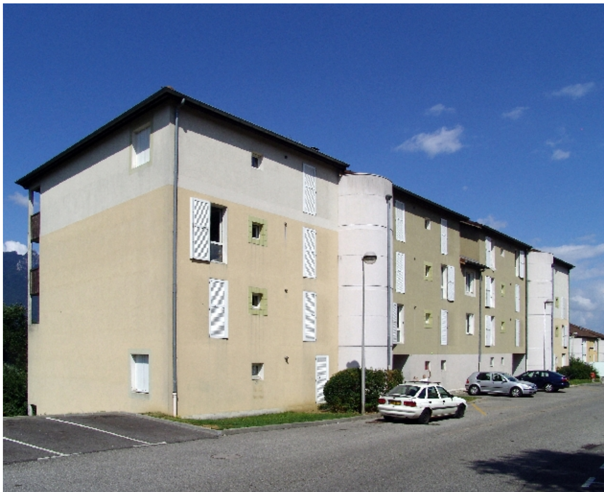
Façade antérieure d'un immeuble vue de trois-quart
