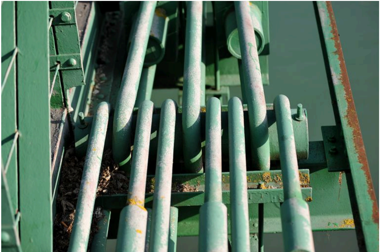
Tablier, vue de détail : ancrage des câbles porteurs
