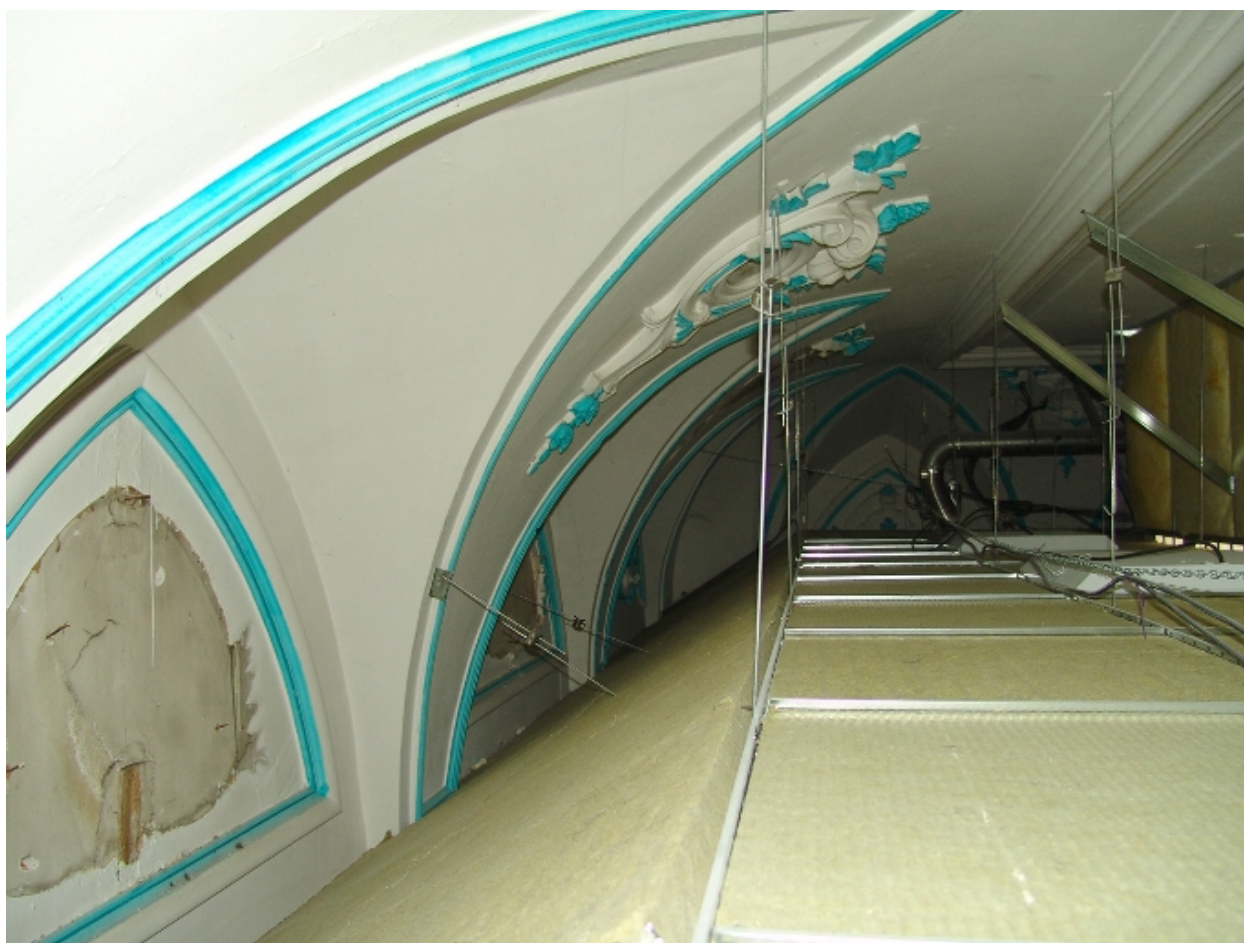
Détail de la voûte
