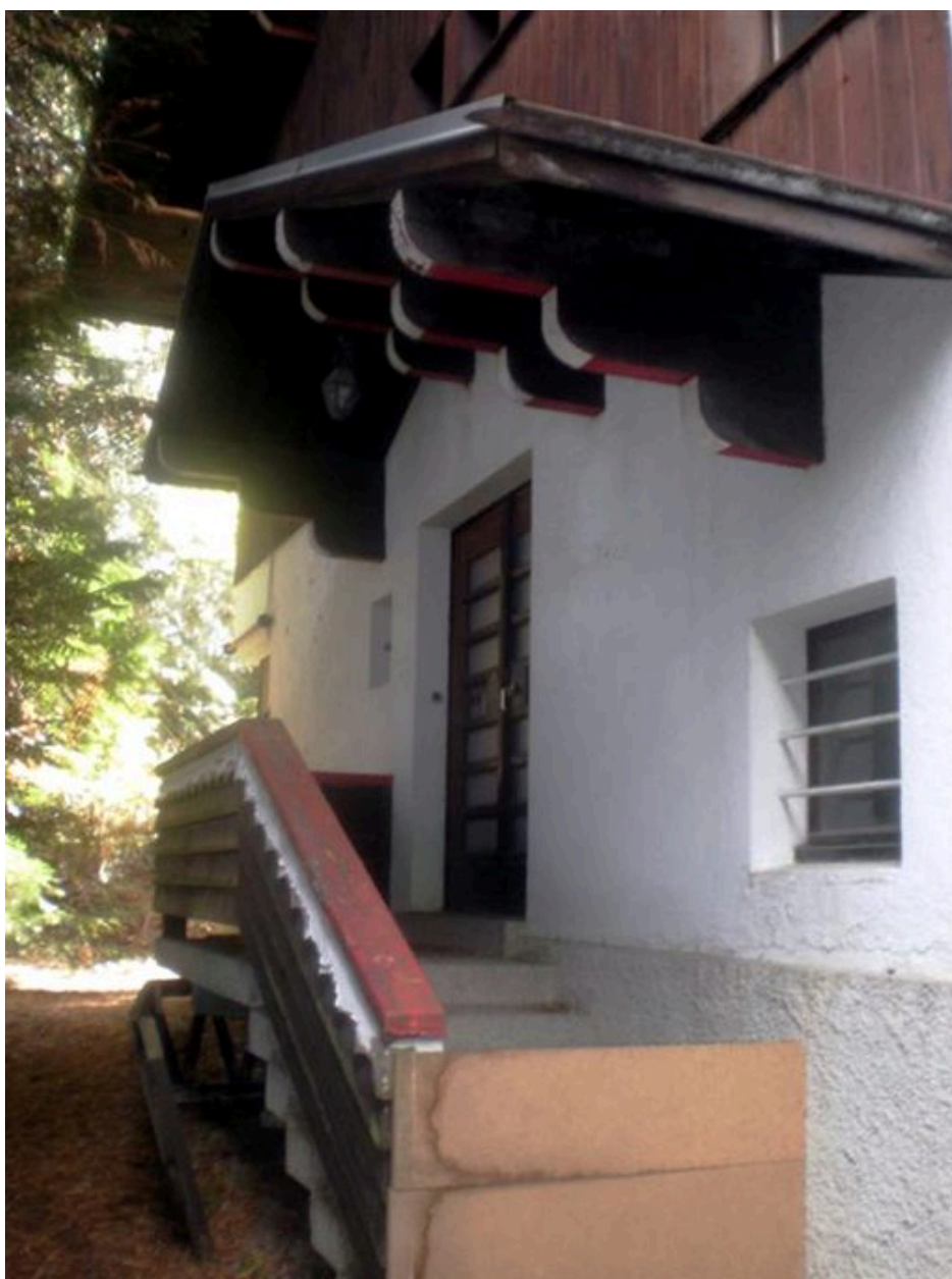
Le perron de la façade nord, surmonté d'un auvent
