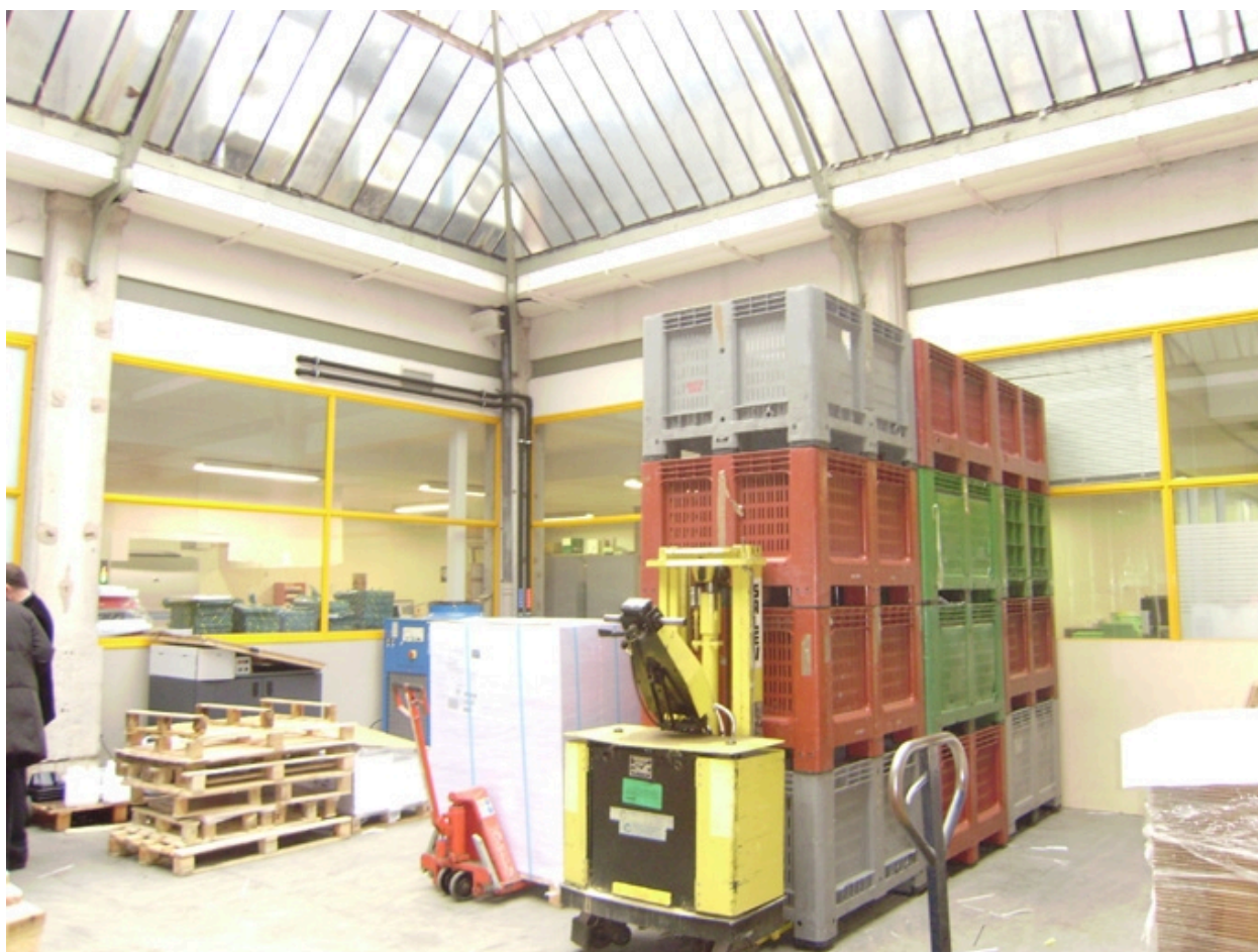
Stockage sous la verrière
