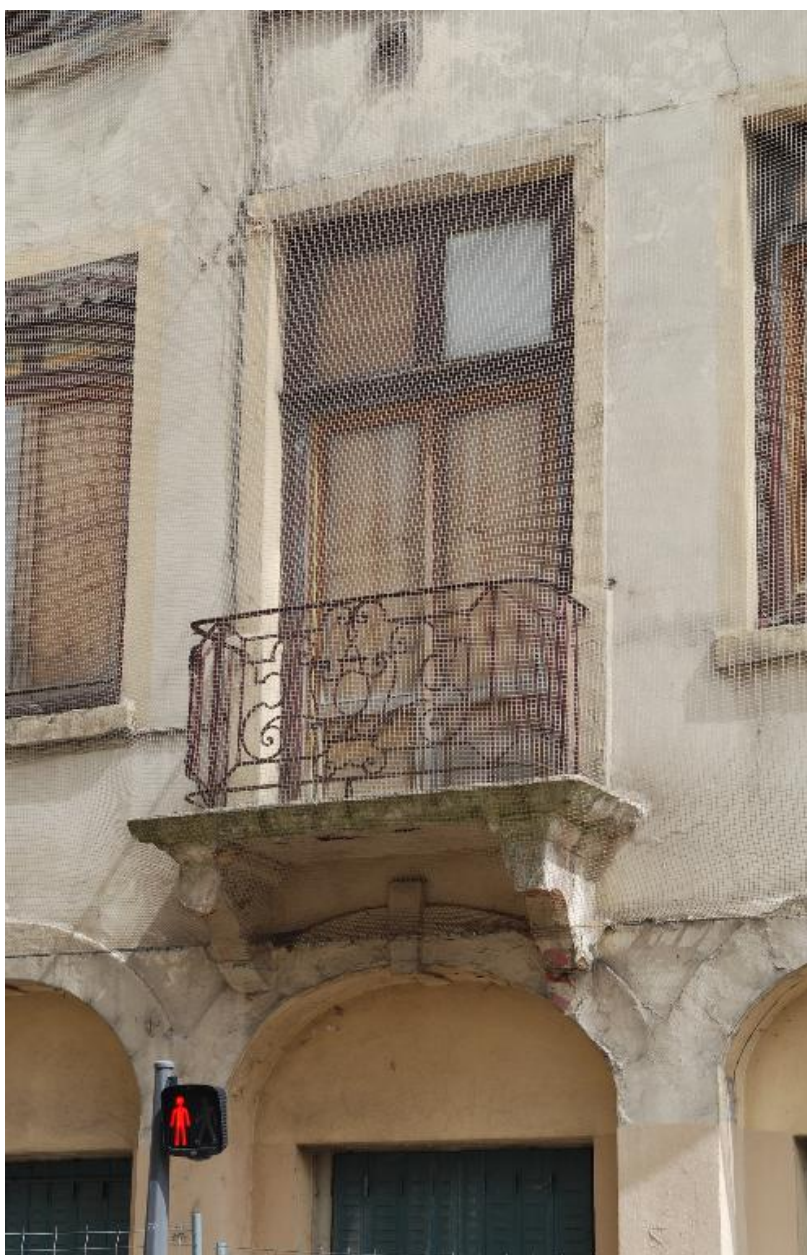
Elévation sur la rue Baraban, premier étage : vue rapprochée du balcon
