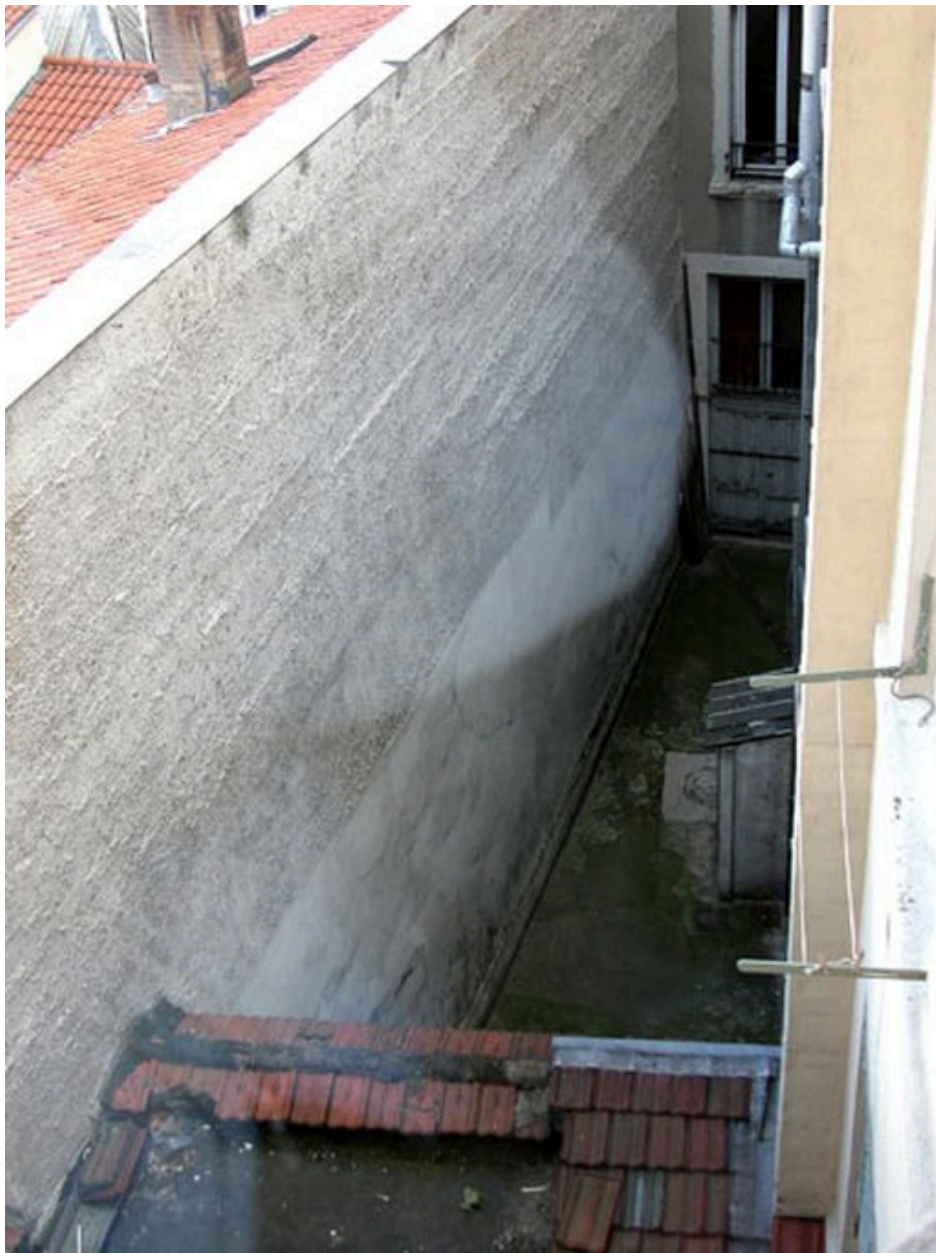
Vue de la cour depuis le 16 avenue Jean-Jaurès
