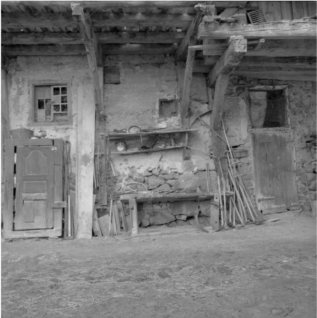
Détail de l'élévation antérieure du logis et de l'étable attenante.
