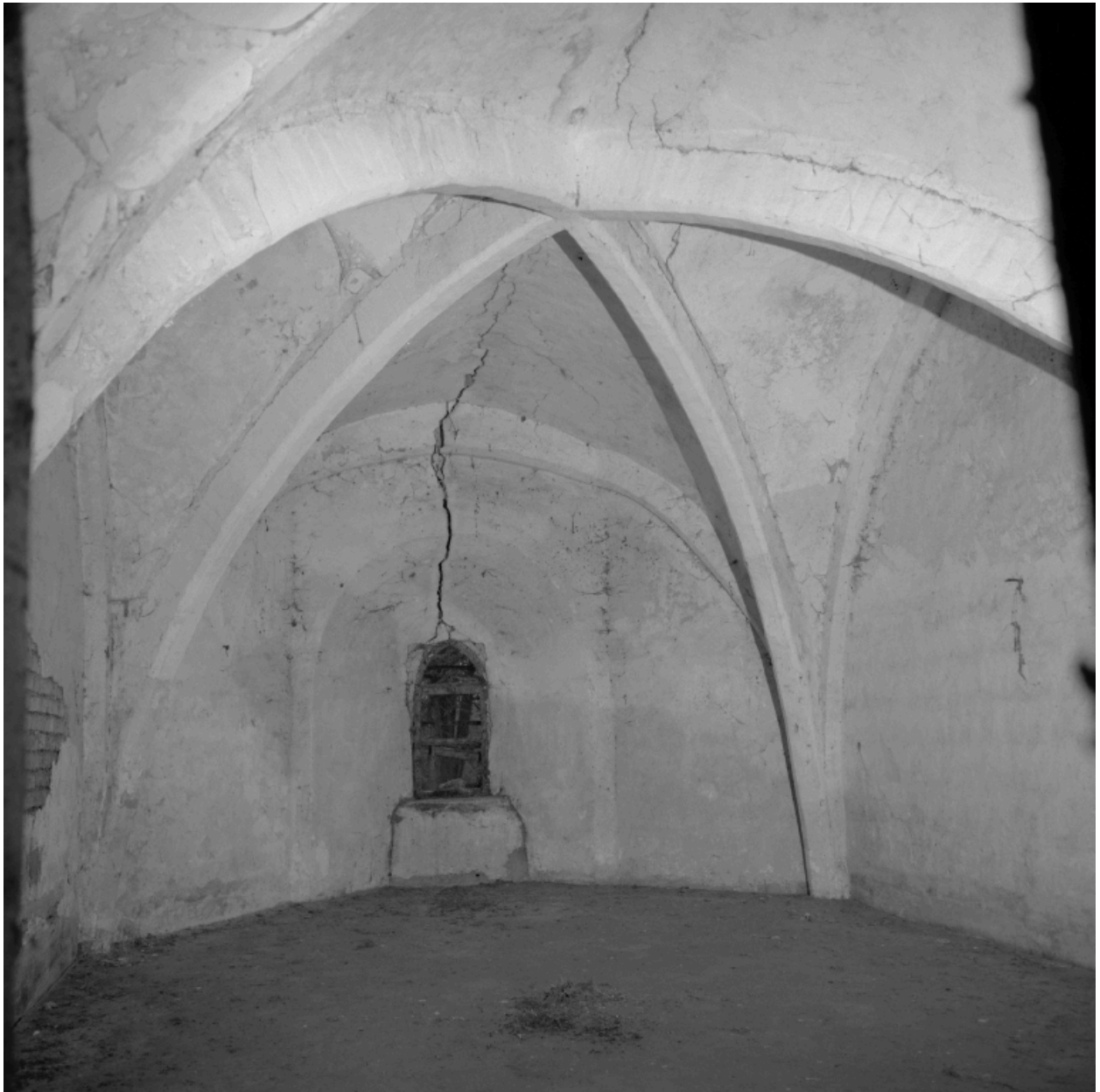
Vue d'ensemble intérieure de l'absidiole sud.
