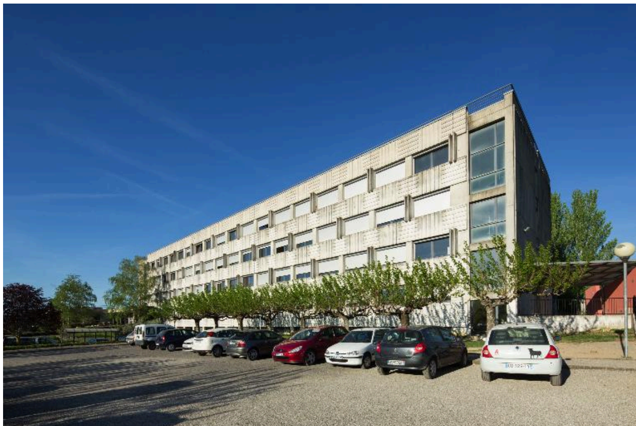
Bâtiment nord : façade est et pignon nord.
