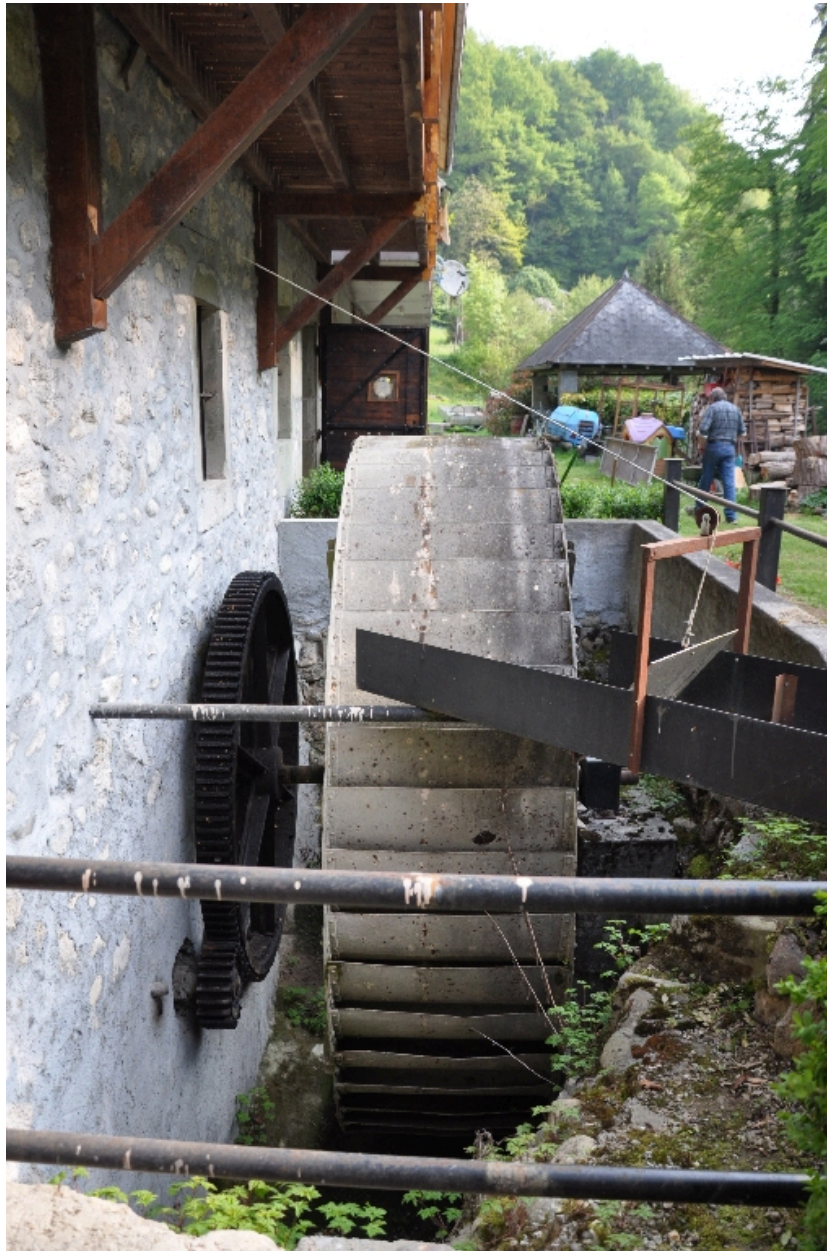
Vue de la roue métallique verticale avec l'arrivée d'eau.
