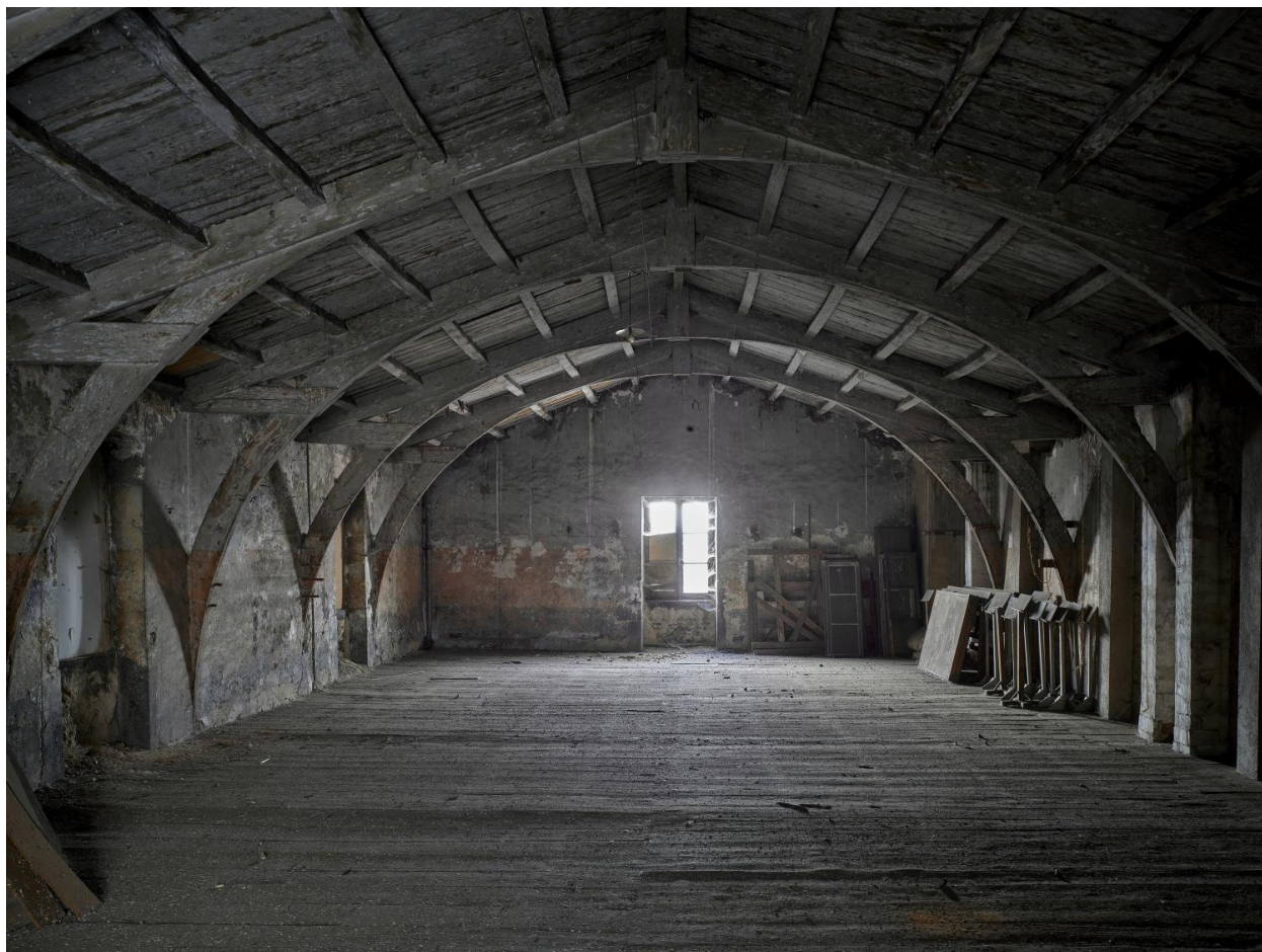
Corps de bâtiment nord : comble
