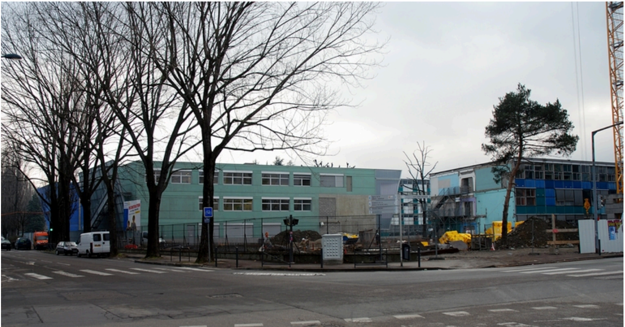
Vue générale depuis l'est, en 2009
