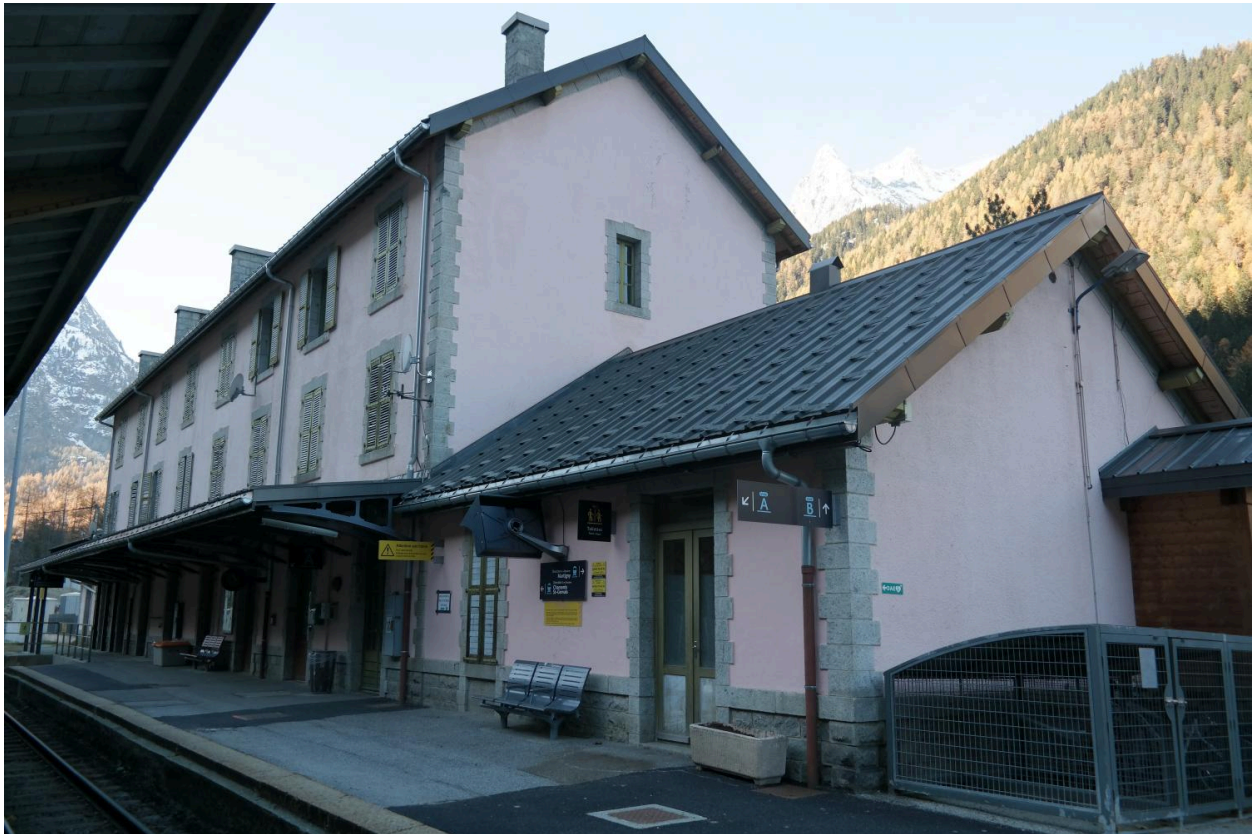
Vue de la façade postérieure de la gare de Vallorcine
