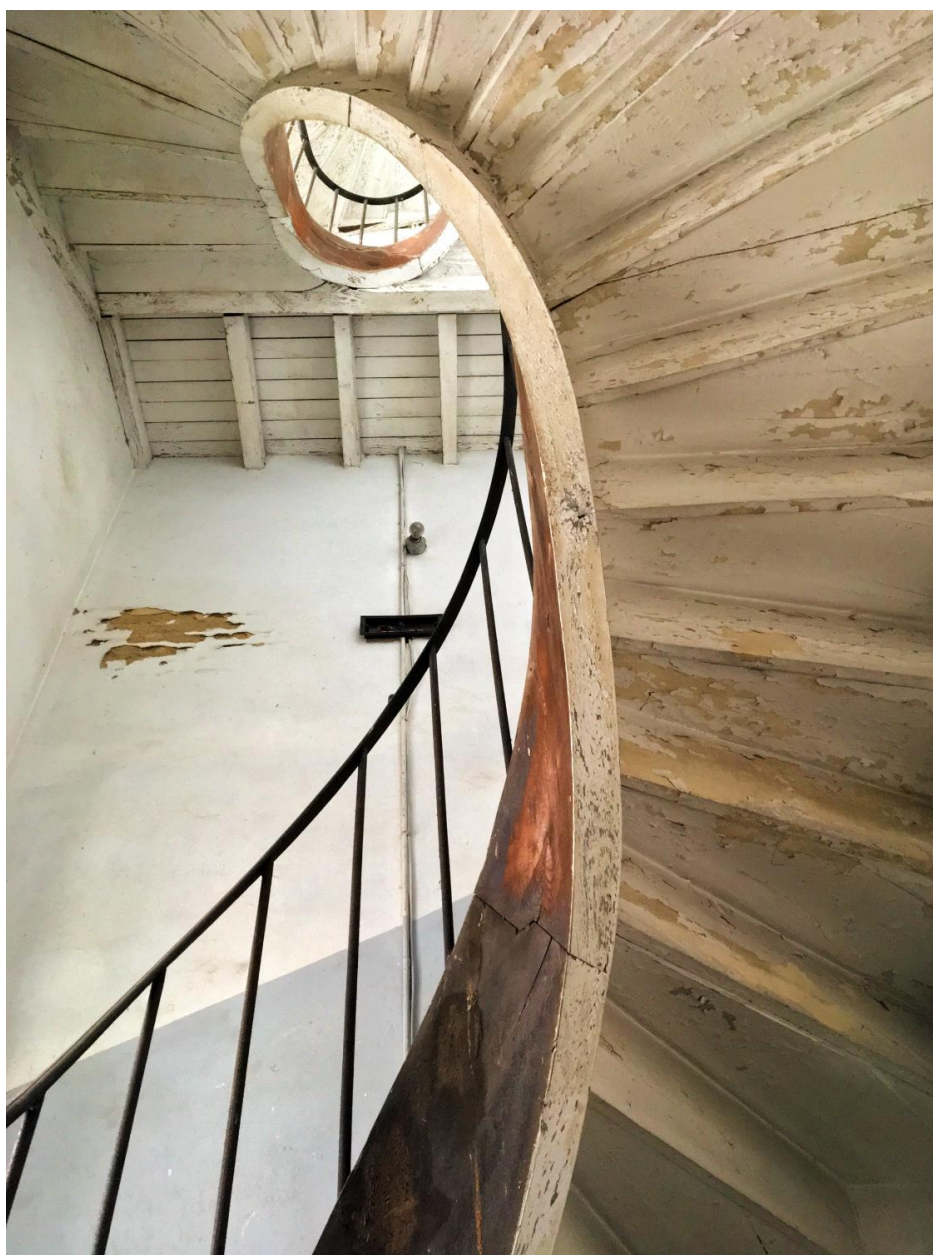
Escalier suspendu en vis, tour sud
