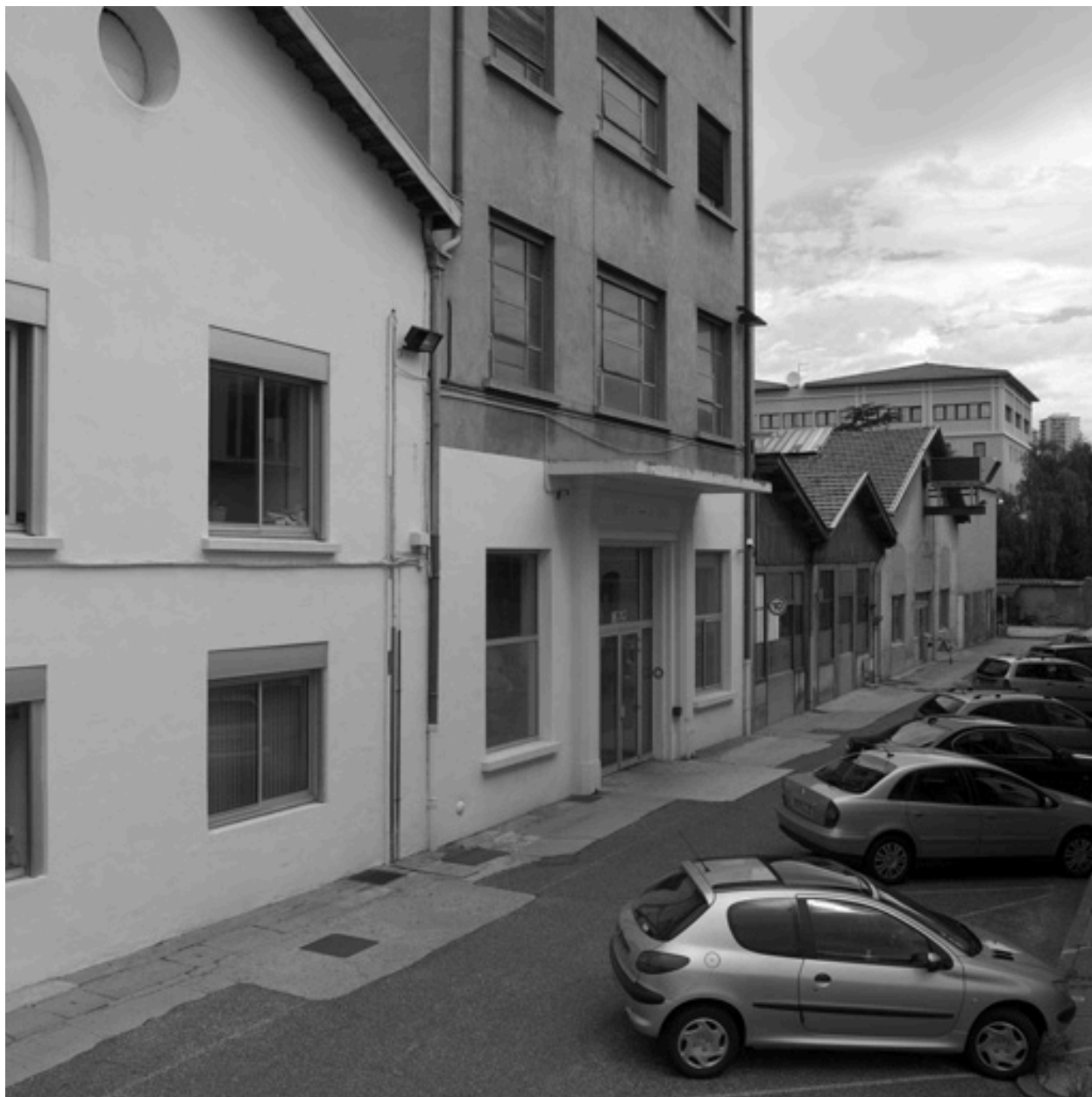
Entrée de l'ancien atelier tréfilerie
