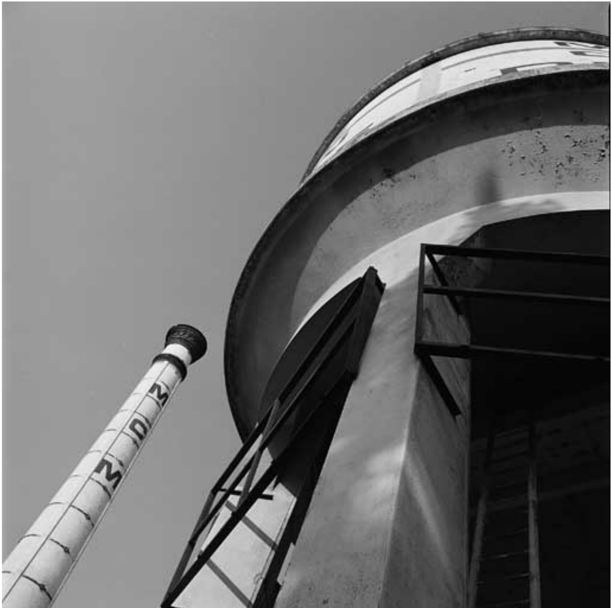
Château d'eau et cheminée, vue nord
