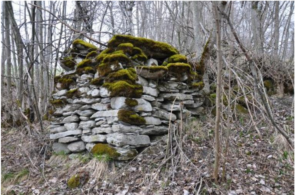
Muret de pierre soutenant la dérivation immédiatement en amont des vestiges du moulin.
