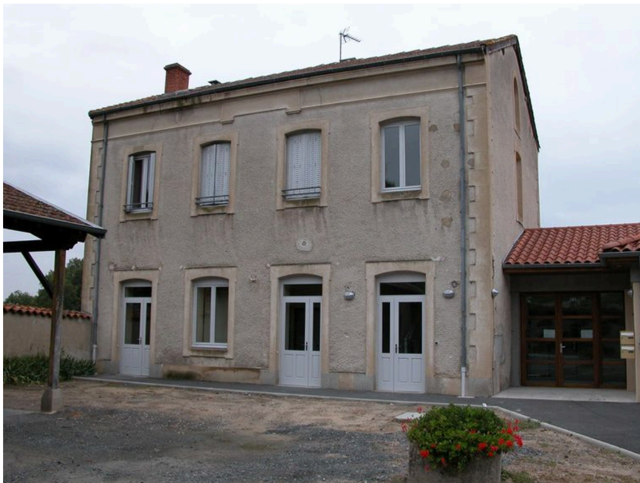
Vue d'ensemble côté cour.
