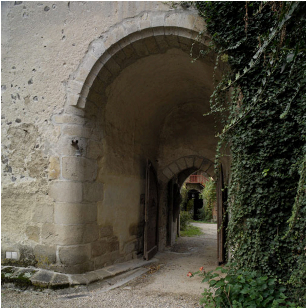
Vue du porche d'entrée du château, depuis l'est.
