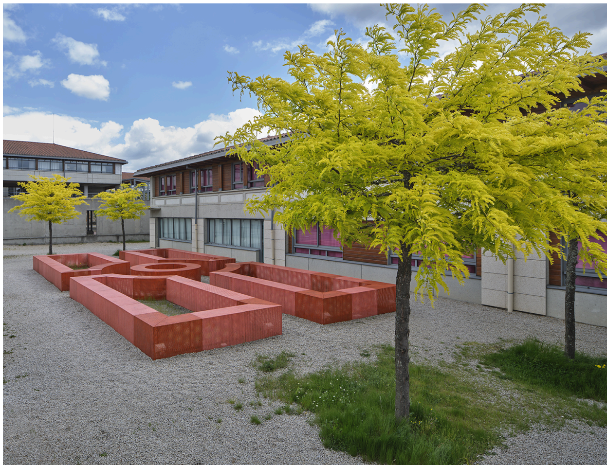
Vue d'ensemble depuis l'ouest
