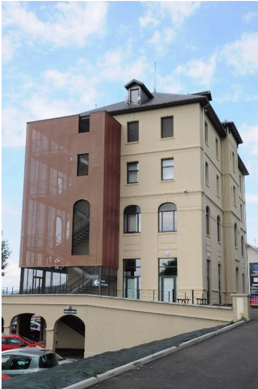
Vue d'ensemble depuis le boulevard
