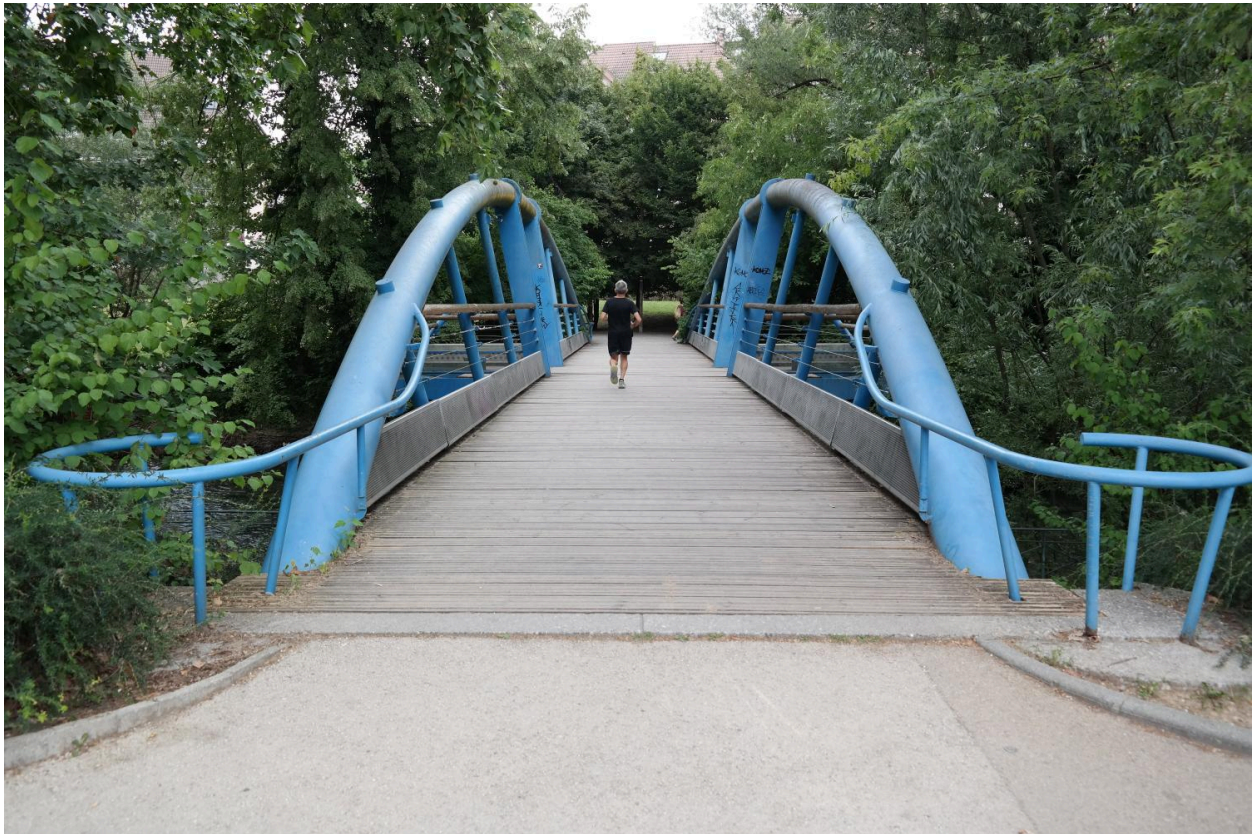
Passerelle piétonne sur le Thiou, vue de la chaussée
