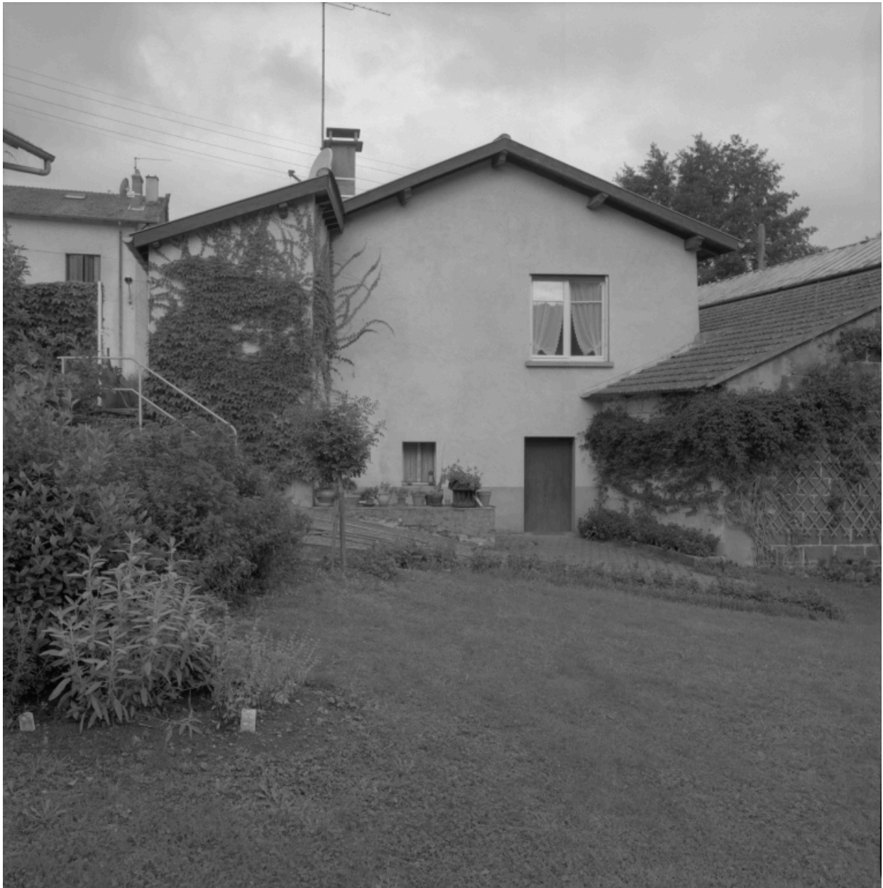
Vue d'ensemble du bâtiment de fabrication d'électricité.
