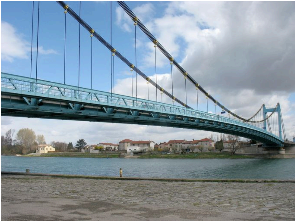
Vue de la face aval (depuis la rive droite)
