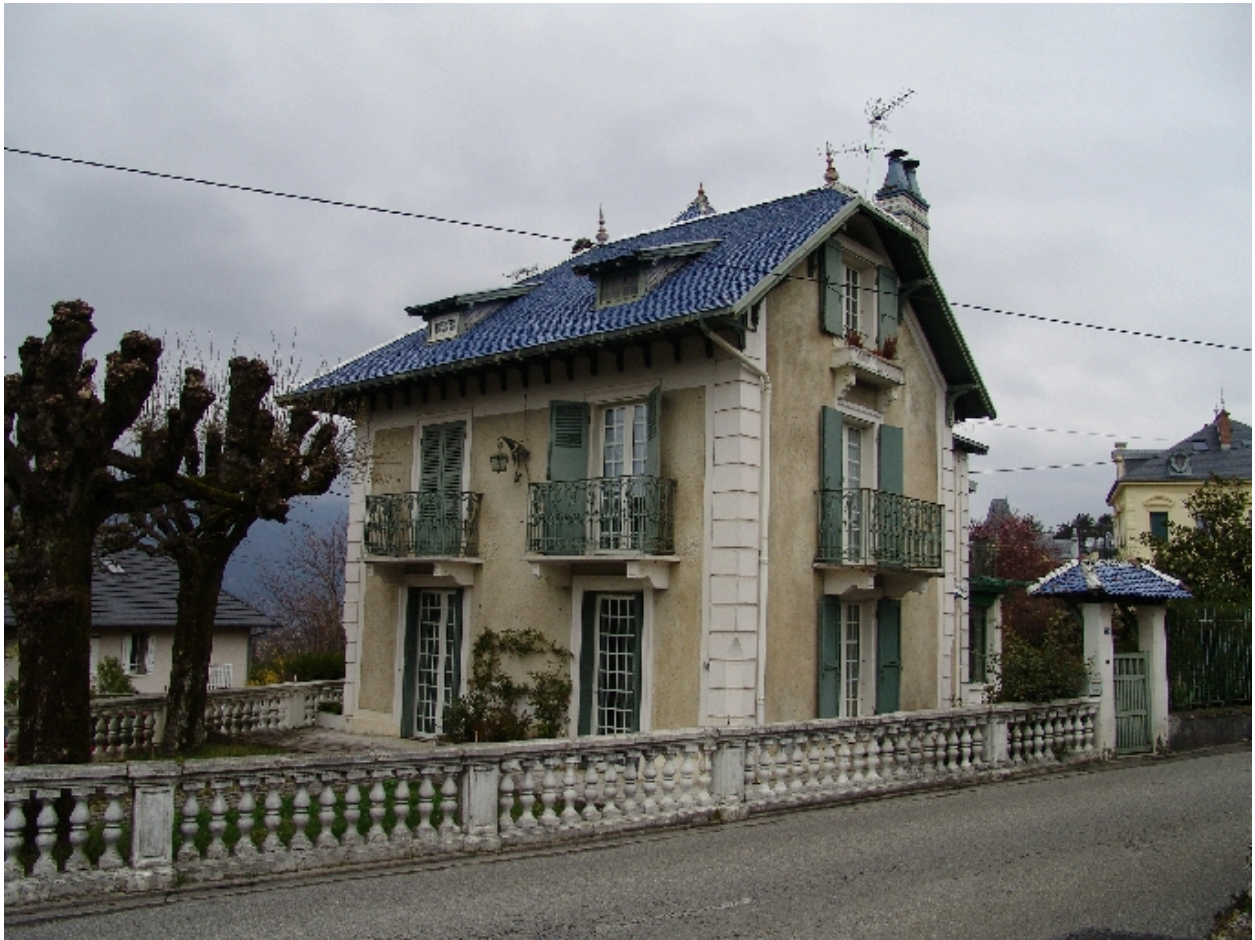
Vue générale du sud-est
