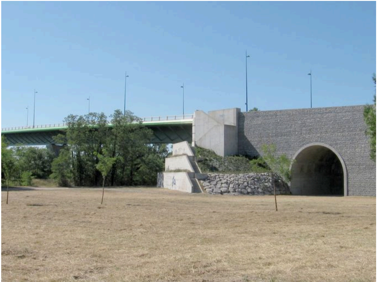
Culée droite, face amont, vue générale (depuis la rive droite)
