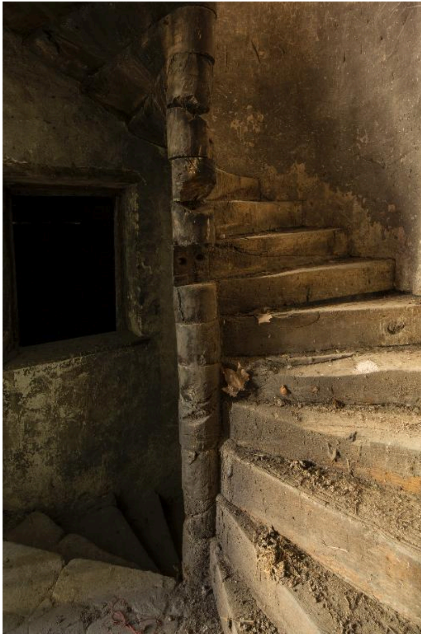
Bâtiment D. Escalier à vis : partie supérieure en bois
