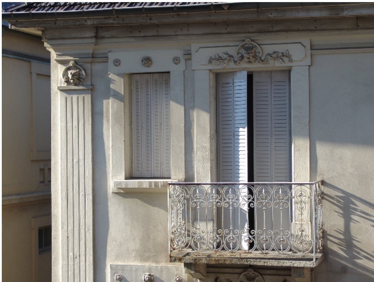
Détail de la façade sur la rue des Bains
