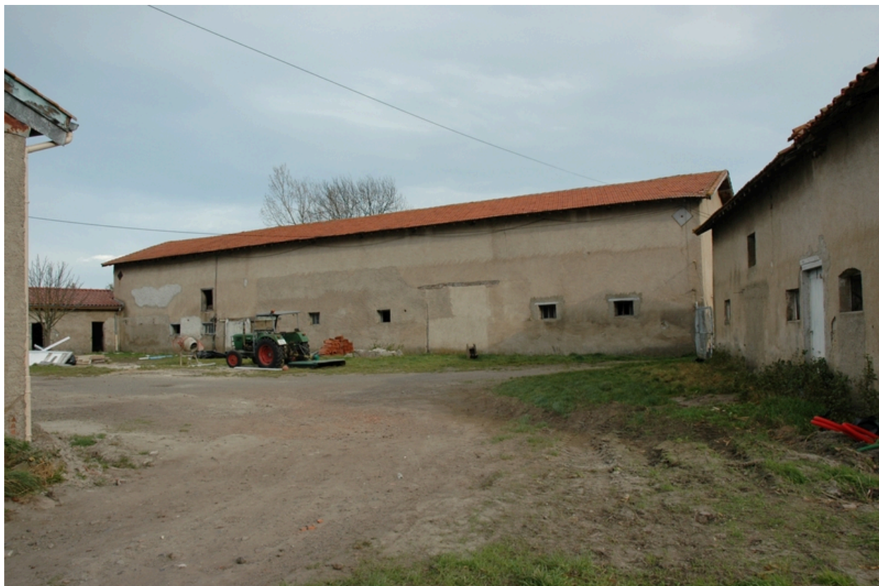
Vue d'ensemble de la grange-étable, depuis l'ouest.
