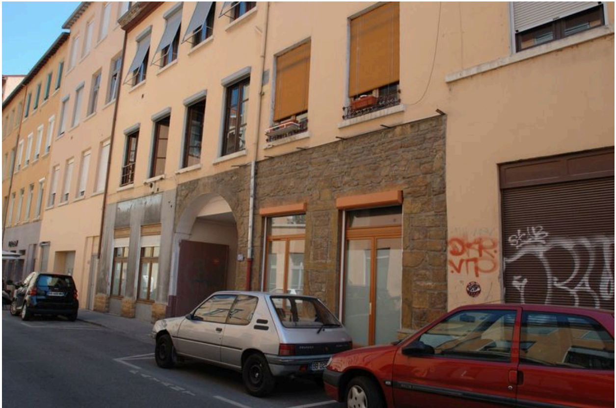
Détail du rez-de-chaussée.
