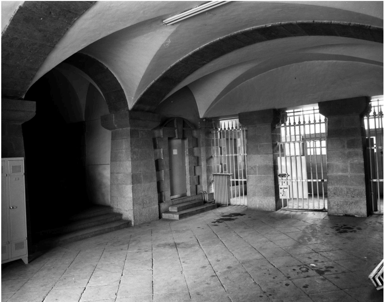
Bâtiment de l'administration (G), vestibule, angle sud-ouest.
